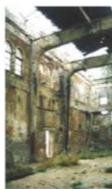
Εικ. 61. Εσωτερικό του πύργου με λεπτομέρεια των πλαισίων μπετόν-αρμέ.
